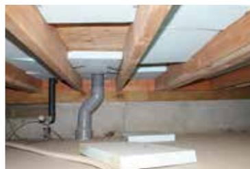
脱落したボード系断熱材
