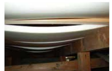
変形したボード系断熱材
