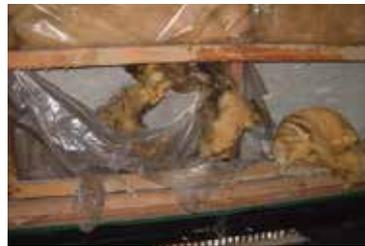
結露により劣化した断熱材
