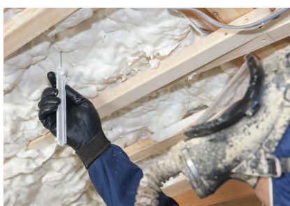
4 施工後チェック
