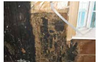
結露によりカビが生えた断熱材
