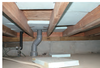
脱落したボード系断熱材
