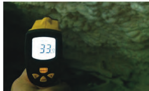
施工前と施工後の温度の違い(小屋裏) ※本データは効果を保証するものではありません。
