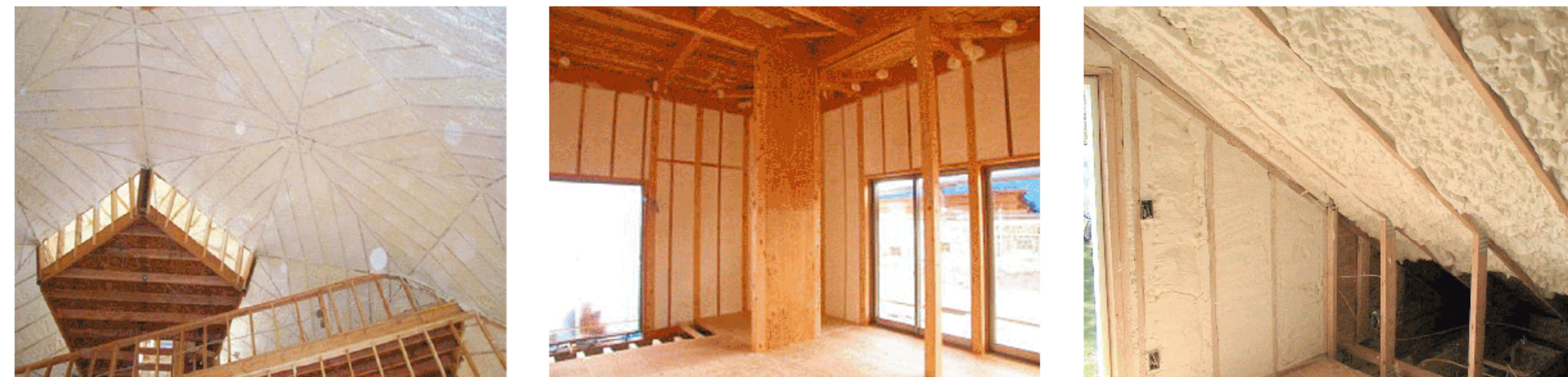
ドームハウス(屋根)
