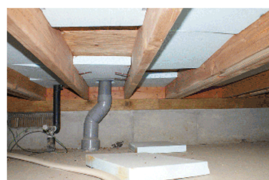
脱落したボード系断熱材
