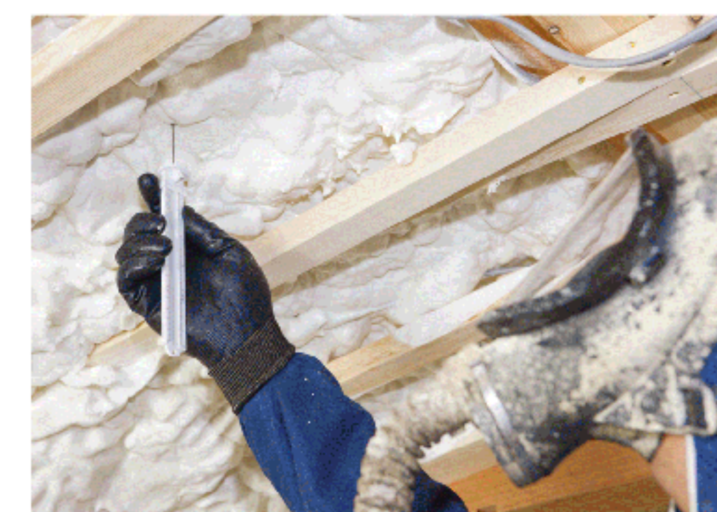
4 施工後チェック
